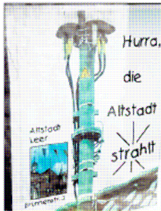
In der Hellingstraße machen Anlieger ihrem Unmut über die Mobilfunkantenne Luft.
